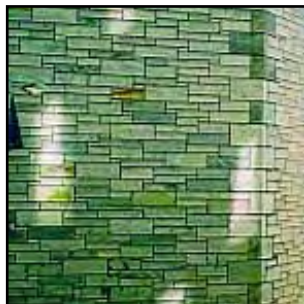
Hyd yn oed os deuant o ffynhonnell leol, dylid osgoi defnyddio defnyddiau yn amhriodol – mae'r llechi crog (chwith) er yn ddull adeiladu traddodiadol, yn ymddangos yn drwsogl ar raddfa fach; mae'r cerrig rwbel wedi'u torri ar hap â pheiriant yn debycach i gerrig wyneb na blociau cerrig chwarel
