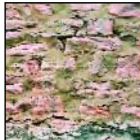
Mae gwaith pwyntio o sment caled, yn enwedig os yw o ansawdd gwael (chwith), a phwyntio rhubanog (dde) yn hyll a gall niweidio gwaith cerrig; bydd y mortar yn cracio i fwrdd oddi wrth y cerrig, gan adael i ddŵr glaw a rhew dreiddio i'r wal; mae'n anhydraidd hefyd, sy'n atal y ffabrig rhag sychu, gan annog treiddiad lleithder i'r tu mewn
