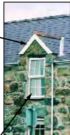
Mae gwaith pwyntio o sment caled, yn enwedig os yw o ansawdd gwael (chwith), a phwyntio rhubanog (dde) yn hyll a gall niweidio gwaith cerrig; bydd y mortar yn cracio i fwrdd oddi wrth y cerrig, gan adael i ddŵr glaw a rhew dreiddio i'r wal; mae'n anhydraidd hefyd, sy'n atal y ffabrig rhag sychu, gan annog treiddiad lleithder i'r tu mewn
