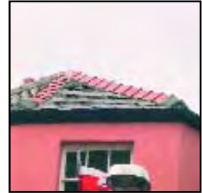
Mae angen cyplysu atgyweirio effeithiol â manylwaith addas – difethwyd ffurf osgeddig y to a gwaith llechi da gan deils ystlys rhy fawr
