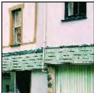
Hyd yn oed os deuant o ffynhonnell leol, dylid osgoi defnyddio defnyddiau yn amhriodol – mae'r llechi crog (chwith) er yn ddull adeiladu traddodiadol, yn ymddangos yn drwsogl ar raddfa fach; mae'r cerrig rwbel wedi'u torri ar hap â pheiriant yn debycach i gerrig wyneb na blociau cerrig chwarel
