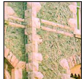
Mae gwaith pwyntio o sment caled, yn enwedig os yw o ansawdd gwael (chwith), a phwyntio rhubanog (dde) yn hyll a gall niweidio gwaith cerrig; bydd y mortar yn cracio i fwrdd oddi wrth y cerrig, gan adael i ddŵr glaw a rhew dreiddio i'r wal; mae'n anhydraidd hefyd, sy'n atal y ffabrig rhag sychu, gan annog treiddiad lleithder i'r tu mewn
